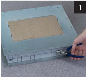
Завести в люк кабели, гофрированные трубы, лотки
