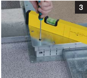
При помощи регулировочных винтов выставить уровень
