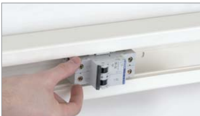
Установить автомат в кабельканал до щелчка
