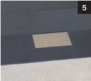
Монтаж покрытия поверхности пола
